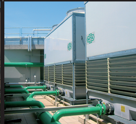
LE TORRI di raffreddamento installate sono 4 a ventilatore assiale, a doppia cella, e 2 monocella, sempre a ventilatore assiale, con potenzialità termica complessiva di oltre 6 MW.
