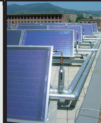
SOLARE TERMICO. I pannelli impiegati per il riscaldamento dell'acqua.
