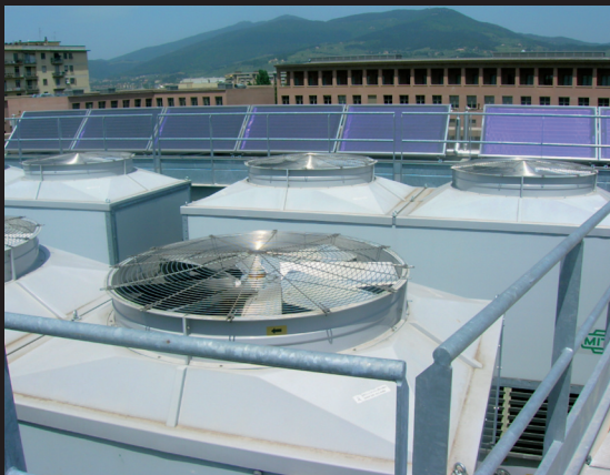
LE TORRI di raffreddamento installate sono 4 a ventilatore assiale, a doppia cella, e 2 monocella, sempre a ventilatore assiale, con potenzialità termica complessiva di oltre 6 MW.
