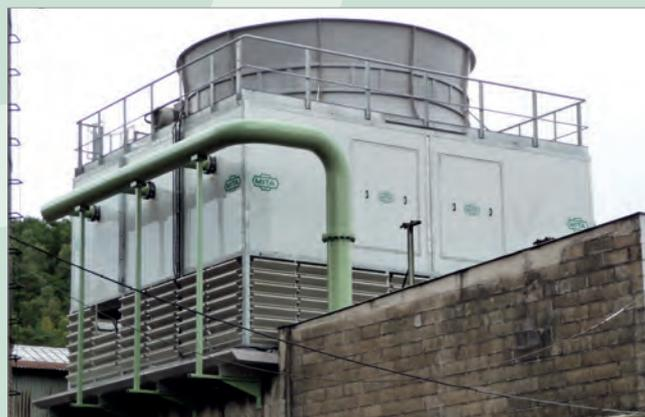
Impianto dopo la sostituzione con moduli MITA
