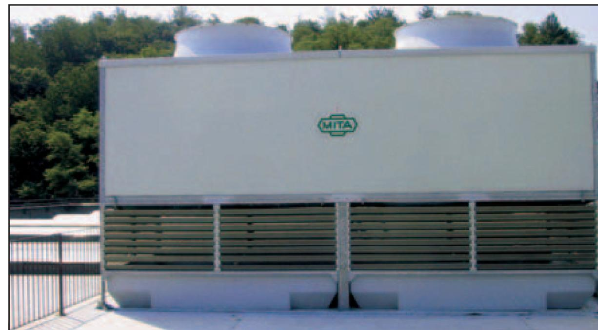
L'impianto di raffreddamento realizzato presso lo stabilimento di Cesana Brianza comprende tre torri Mita serie PME Super Silent installate sui circuiti di raffreddamento dei forni ad induzione, scelte per ridurre al minimo il rischio di un'interruzione del processo di raffreddamento e per ridurre la rumorosità dell'impianto
