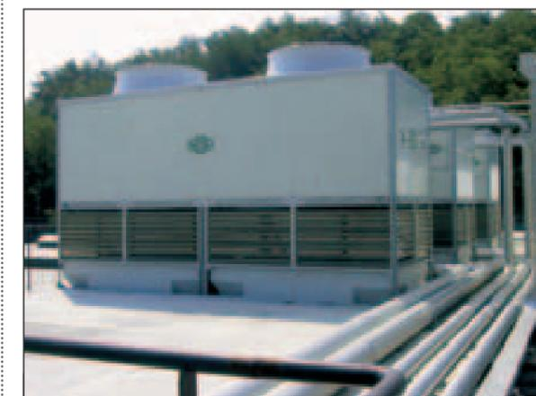
La capacità totale è di 120.000 l; due serbatoi da 30.000 l ciascuno raccolgono l'acqua calda proveniente dal ciclo produttivo e quattro pompe (dalla portata di 200 m<sup>3</sup>/ora) la inviano, tramite condotti in acciaio inox, alle torri per il raffreddamento al termine del quale viene stoccata in altri due serbatoi di pari capacità
