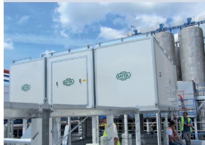
**I CONDENSATORI EVAPORATIVI** impiegati condensano il gas (ammoniaca/NH<sub>3</sub>) necessari per la refrigerazione, a 35 °C con una temperatura al bulbo umido di design di 28 °C.
