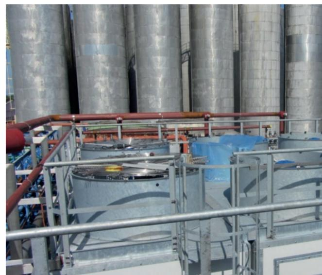
**L'IMPIEGO** dei condensatori ha consentito di ottenere una maggiore potenzialità termica complessiva (pari a 6804 kW), con un ingombro di spazio estremamente contenuto.
