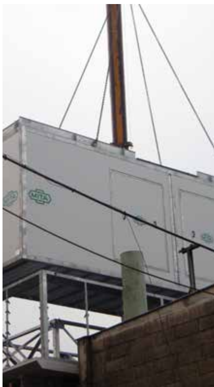
Accompagnamento durante l'installazione.
