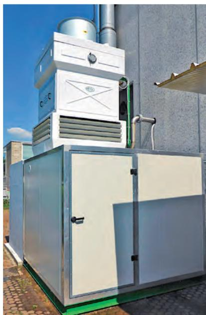
È possibile posizionare al di sopra della centrale una torre evaporativa di medio/piccole dimensioni, cosa che rende tale soluzione l'ideale per impianti di potenzialità contenute.
