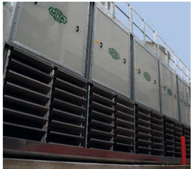
Tutte le torri di raffreddamento della serie **PMM** vengono assemblate con diversi pacchi di scambio termico selezionati in base alla natura dell'acqua da raffreddare e alle esigenze del cliente.
