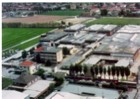
Lo stabilimento Clariant Masterbatches di Pogliano Milanese (MI)
