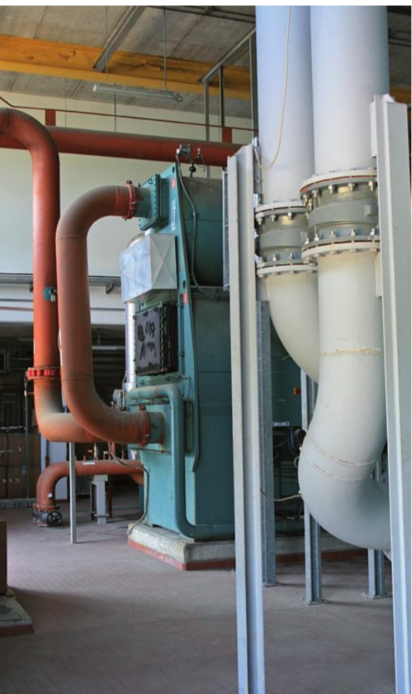
Per la produzione dei circa 8 MW di potenza frigorifera necessari all'ospedale nella sua configurazione finale, sono utilizzati diversi gruppi frigoriferi a compressione centrifughi più un assorbitore monostadio di scorta.
